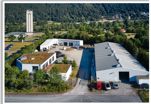
Das neue Gelände in der Alfred-Zippe-Straße
