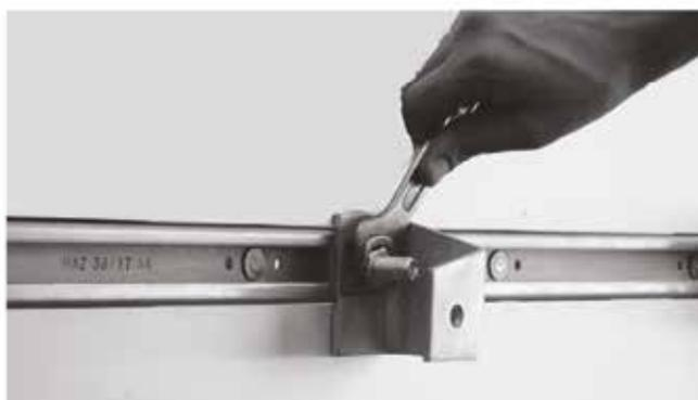
Die zu befestigenden Bauteile werden mit Hammer- oder Hakenkopfschrauben und Muttern gesichert (siehe Abb.). Dabei müssen korrekte Last- und Drehmomentwerte entsprechend der erlaubten Schienen- und Ankerlast angewandt werden.
