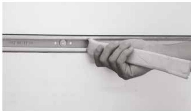
Nach dem Aushärten des Betons wird das Füllmaterial, das dem Zweck dient, das Eindringen von Beton zu vermeiden, aus dem Profil entfernt.
