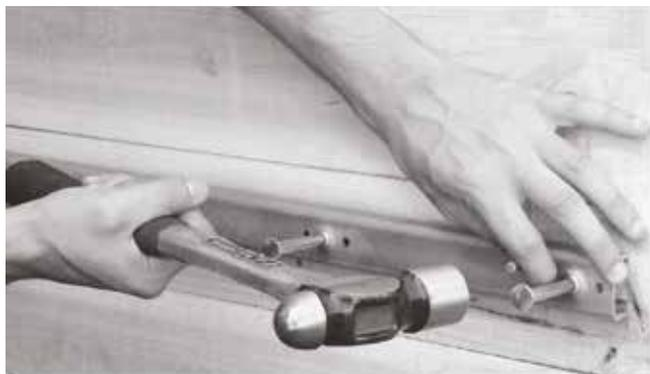
Ankerschienen werden nach sorgfältiger Planung und Platzierung an der Schalung befestigt, beispielsweise mit Nägeln oder Magneten, dann wird der Beton eingegossen.
