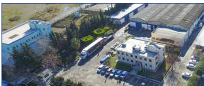
Verwaltungsgebäude in Iskenderun, Türkei
